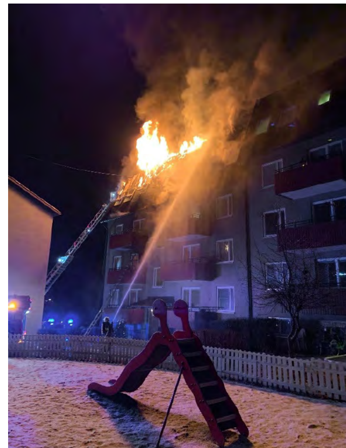
Branden har brutit igenom yttertakets på vinden. Utvärdig släckning pågår.
