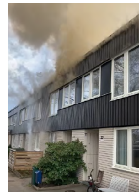
Branden spred sig via den träbekladda fasaden.
