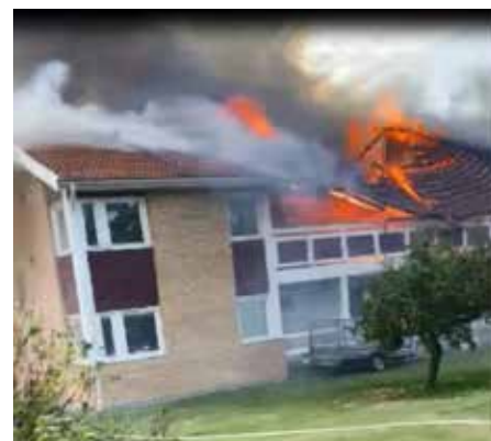
Byggnadens östra långsida 19,5 minuter efter att branden upptäckts. På bilden syns hur taket brinner kraftigt och har rasat in över delar av byggnaden samt över loftgången.
