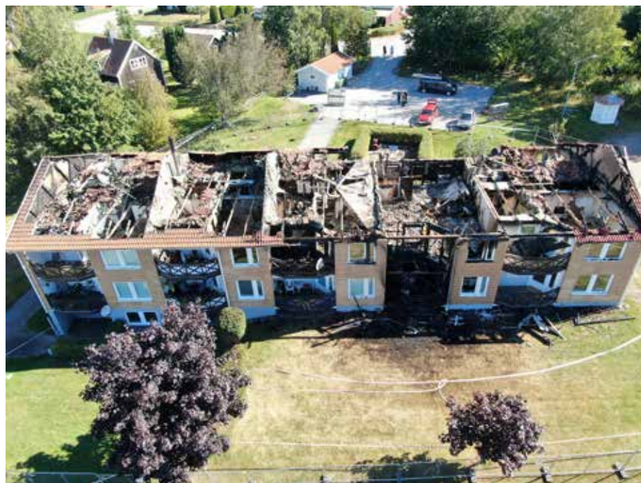
Bild tagen efter att räddningsinsatsen avslutats. Hela takkonstruktionen har rasat in och större delen av betongpannorna ligger på mellanbjälklaget.
