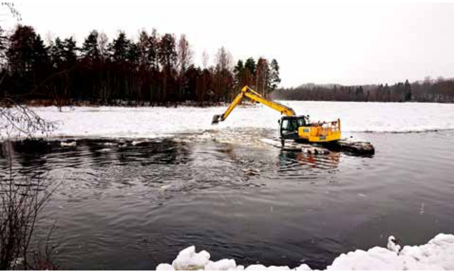
En pontonförsedd grävmaskin gjorde en ränna i isproppen för att få fritt flöde i älven.
