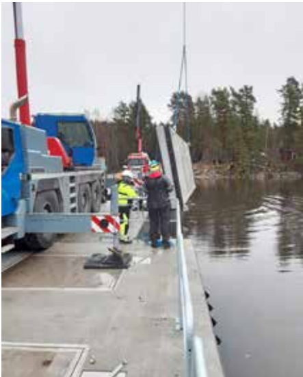
Bild från översvämningsskyddets mobilisering. Statlig delfinansiering via MSB är en viktig förutsättning för den här typen av investeringar i klimatanpassning.
