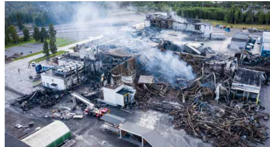
På morgonen efter branden bröt ut hade större delen av byggnaden rasat in.
