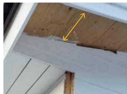
Panel på undersida av gaveltaksprång som kan innebära att råspont saknas. Jämförande bild med råspont där bräddorna under takfot på gaveln löper i husets längdriktning.
