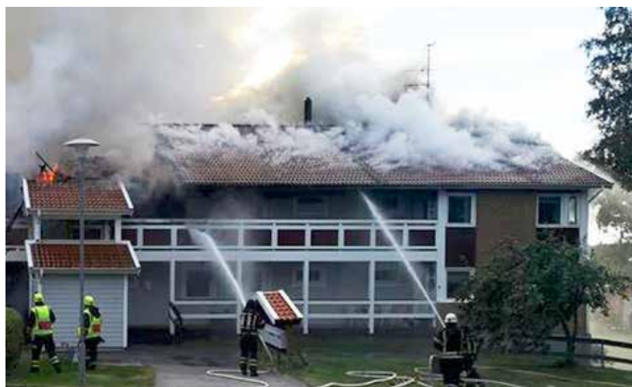
Bild 7. Rökspridning mellan takpannorna på stora delar av taket kan indikera att taket är byggt utan råspont.
