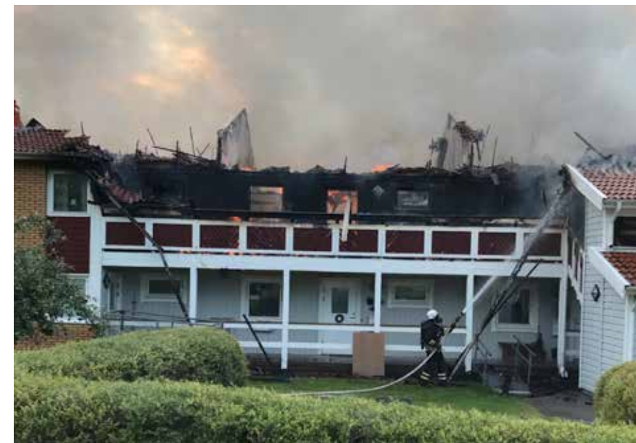
Byggnadens östra långsida 34 minuter efter att branden upptäckts. På bilden syns att taket har rasat in över samtliga lägenheter.
