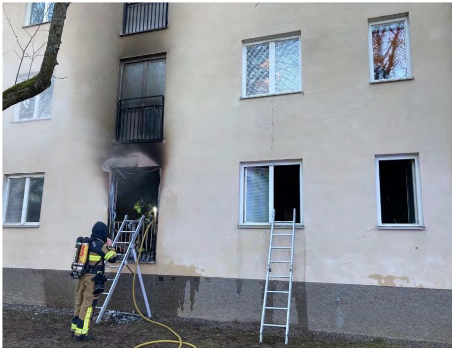
Räddningstjänsten arbetar på baksidan av byggnaden, startutrymme vid den franska balkongen.
