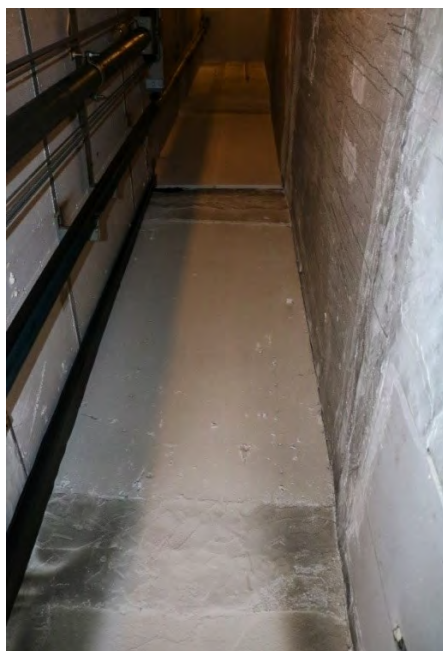
Bild inifrån hisschaktet som visar skivorna man använde för att stänga igen schaktet.
