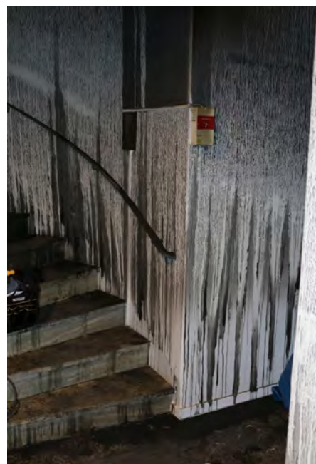
Styrning till röklucka på det branddrabbade våningsplanet.
