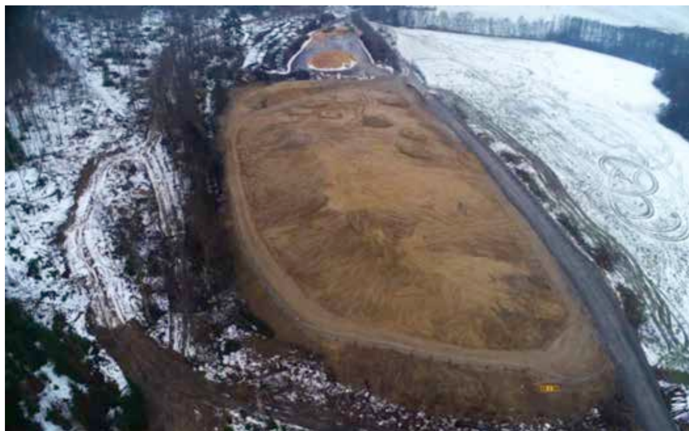
I slutet av februari slutförs täckningsarbetet och ungefär 28 000 m 3 sand har då använts för täckningen.
